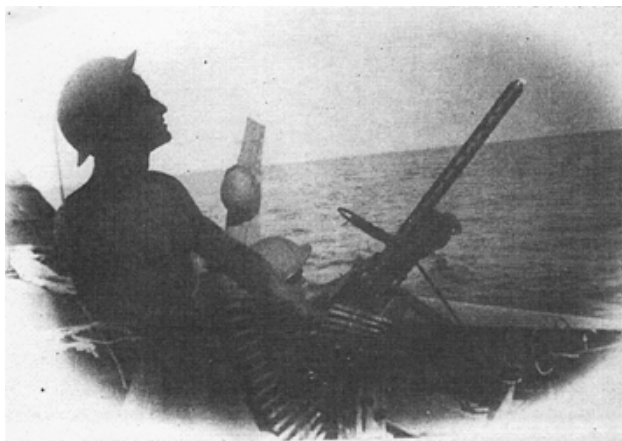
Πολυβόλο Browning .50cal με αεροπορικού τύπου κάννη, σε ελληνικό καταδρομικό καΐκι (πιθανόν στο LS.24). (Ξηράκης / Ιστορία των 7 ελληνικών καϊκιών)
